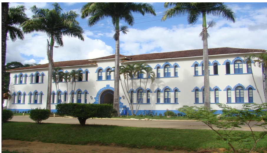
Figura 1 - Prédio principal do IFES - Campus Santa Teresa Foto do autor, 2012.
