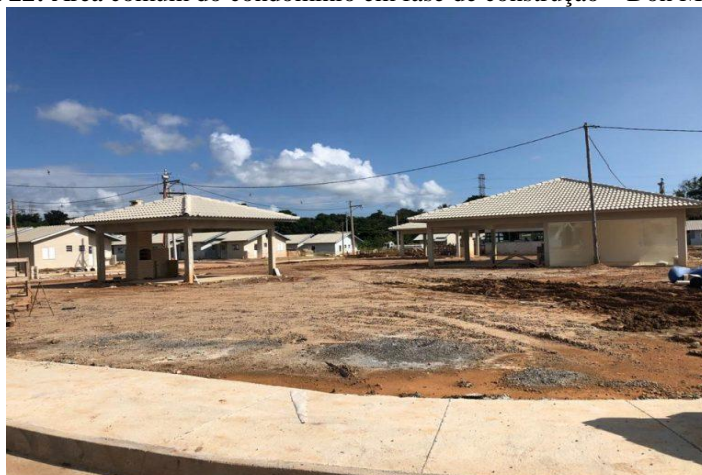
Figura 22: Área comum do condomínio em fase de construção – Don Marcelino
