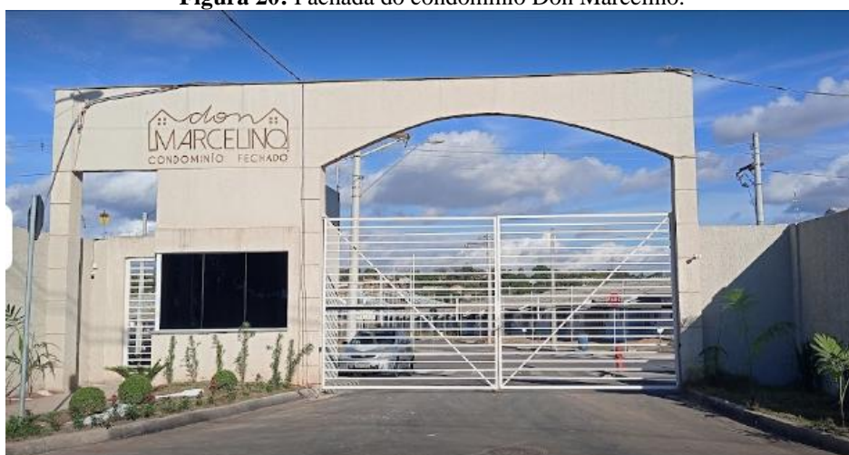
Figura 20: Fachada do condomínio Don Marcelino.
