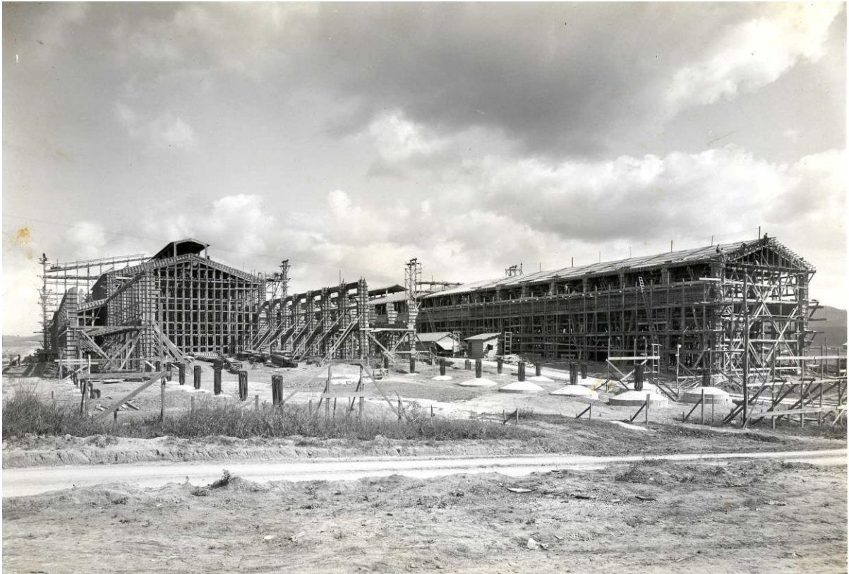
Figura 7: Construção da Companhia Siderúrgica Nacional – fundição (1942)
