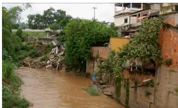
Figura 60: Moradia irregular em área de Proteção permanente do rio Barra Mansa.
