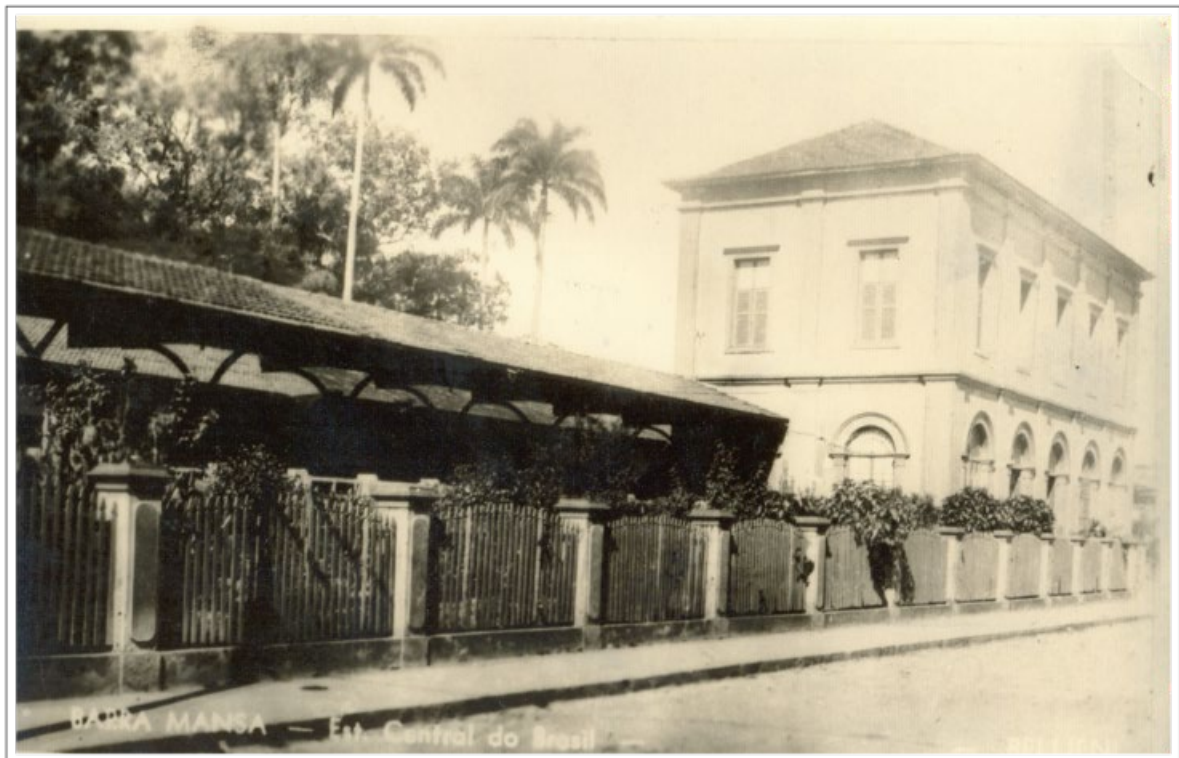
Figura 29: Estação Ferroviária de Barra Mansa, década de 1930
