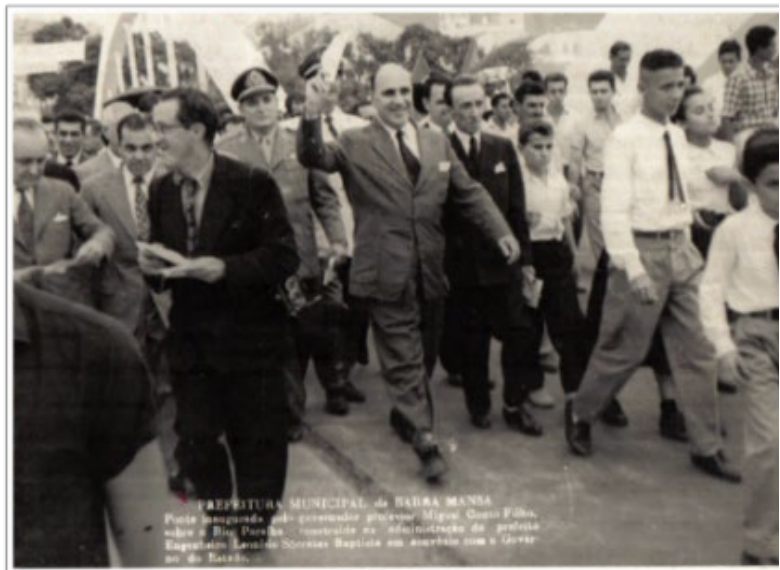
Figura 43: Inauguração da Ponte Ataulpho Pinto dos Reis, 1958
