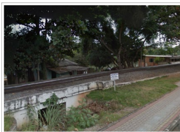
Figura 59: Foto evidenciado moradias irregulares (entre o Rio e a linha férrea), 2015
