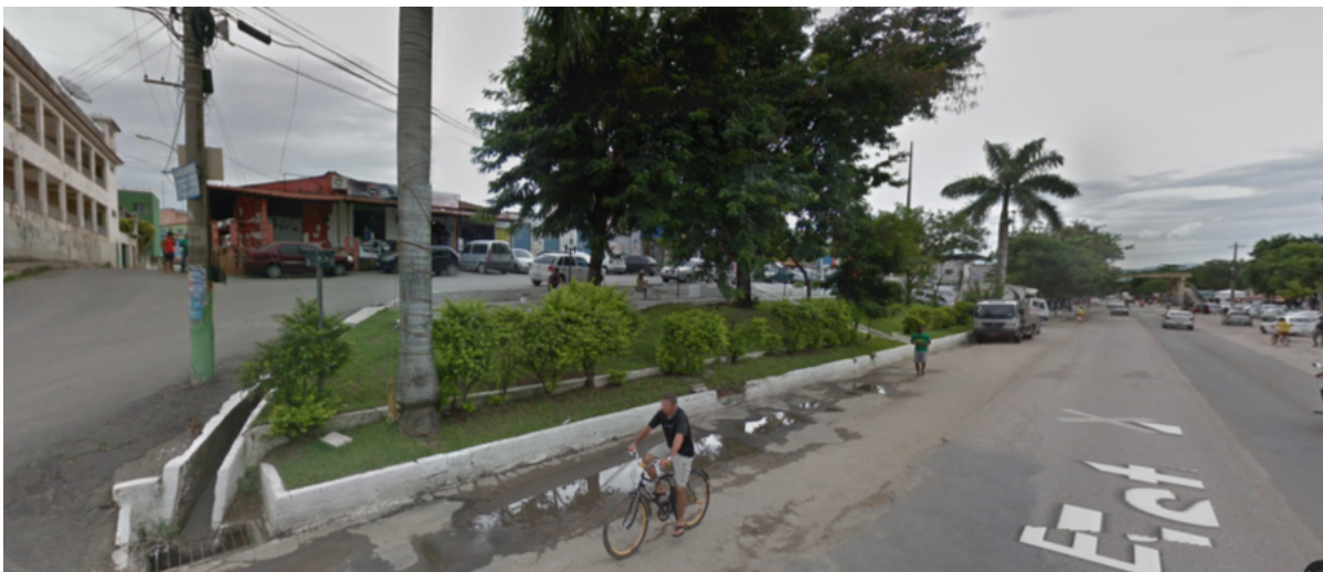
Figura 29 – Rodovia BR-465 com a variação topográfica nos acessos ao Bairro Fazenda Caxias à esquerda.
