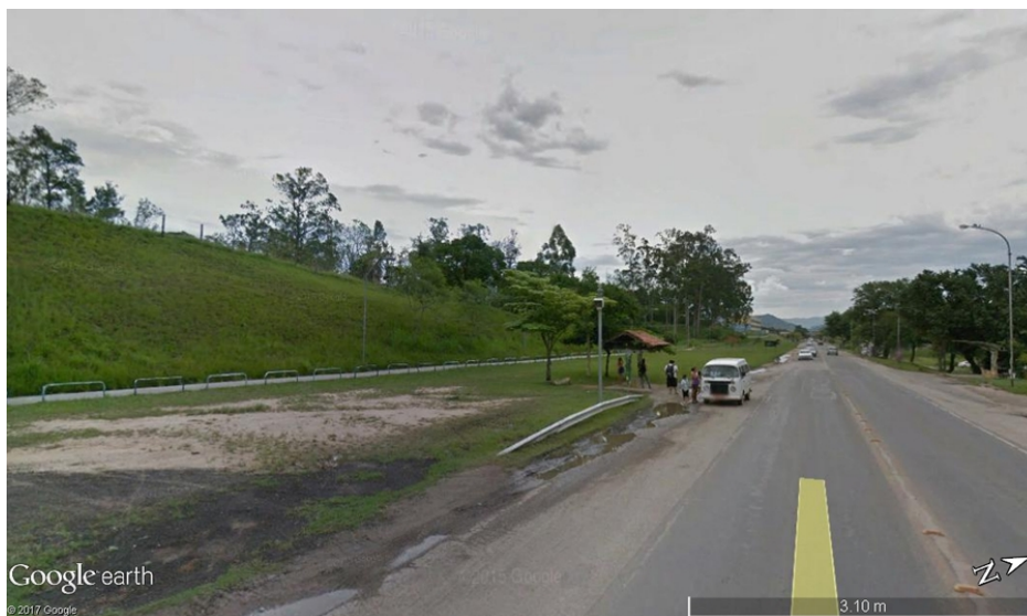
Figura 26 – Talude e ciclovia à esquerda na BR-465.
