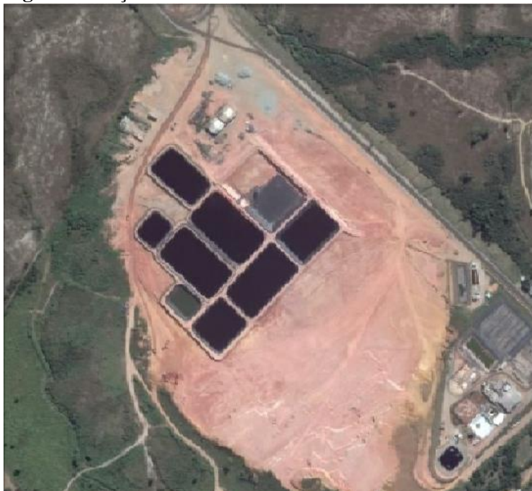
Figura18: Poços de chorume na usina de tratamento do CTR Seropédica
