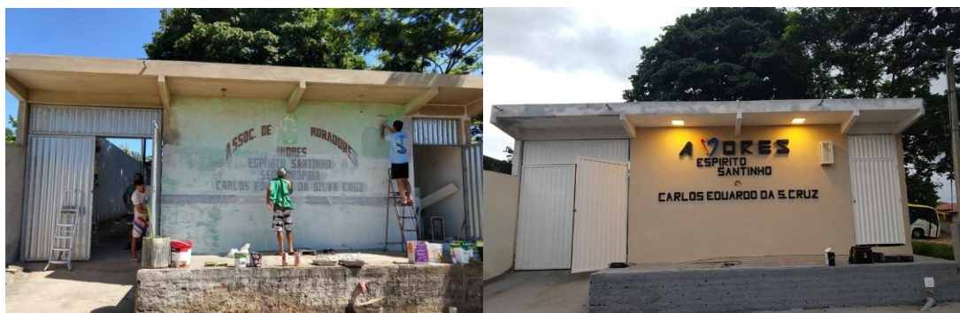
Figura 14. Centro Comunitário e sede da Amores antes e depois das obras de revitalização
