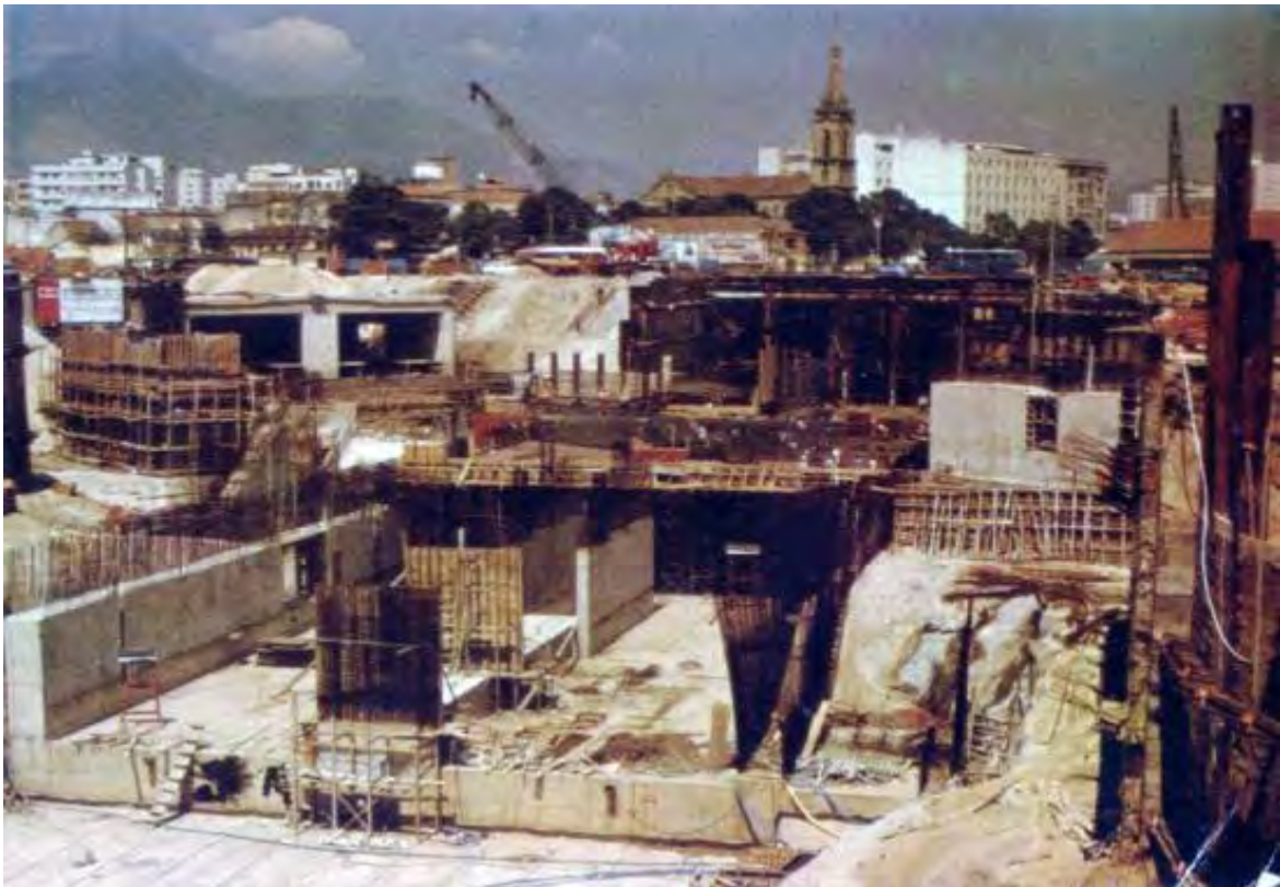
Figura 4: Construção da estação de metrô Estácio, zona norte, Rio de Janeiro. Década de 1970.
