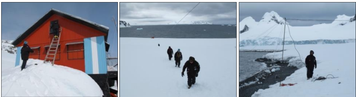
Figura 6: Instalação do cabo guia para o cabo do hidrofone, durante a “Operação Integração Antártica I”. À esquerda, o local de fixação do cabo guia, na janela do sótão da Casa Principal; ao centro, uma visão da altura final do cabo em relação ao solo. À direita, o poste estiado na praia (fotos cedidas pelo Capitão de Fragata Leonardo Martins Barreira).
