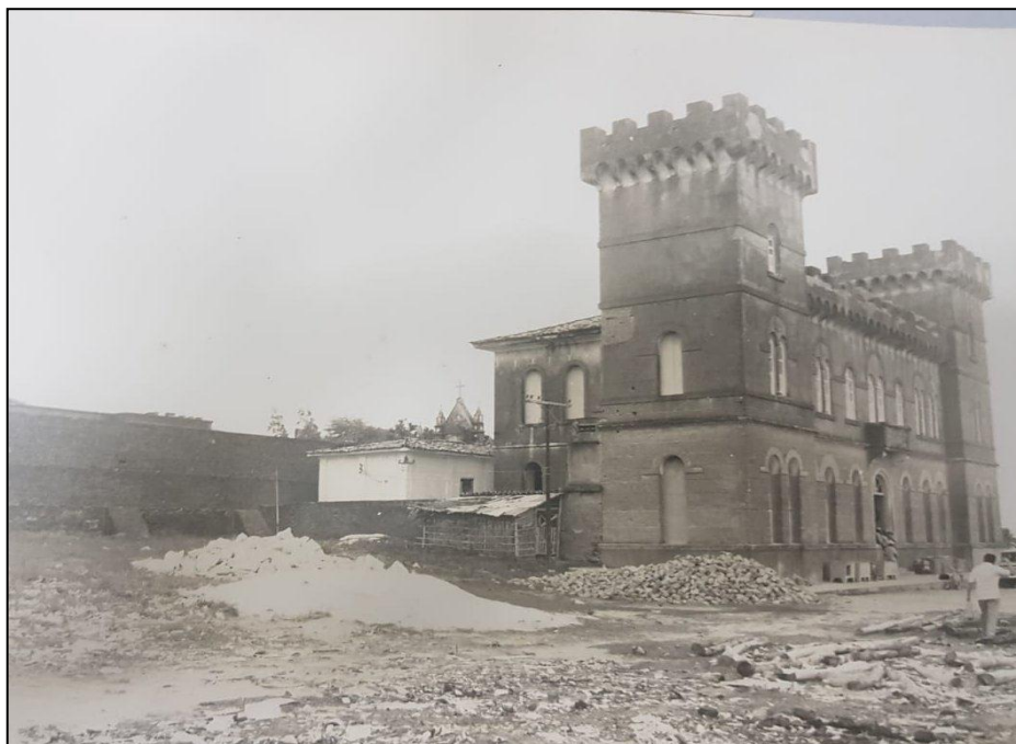
Figura 2 - Construção da Penitenciária Modelo - 1926
